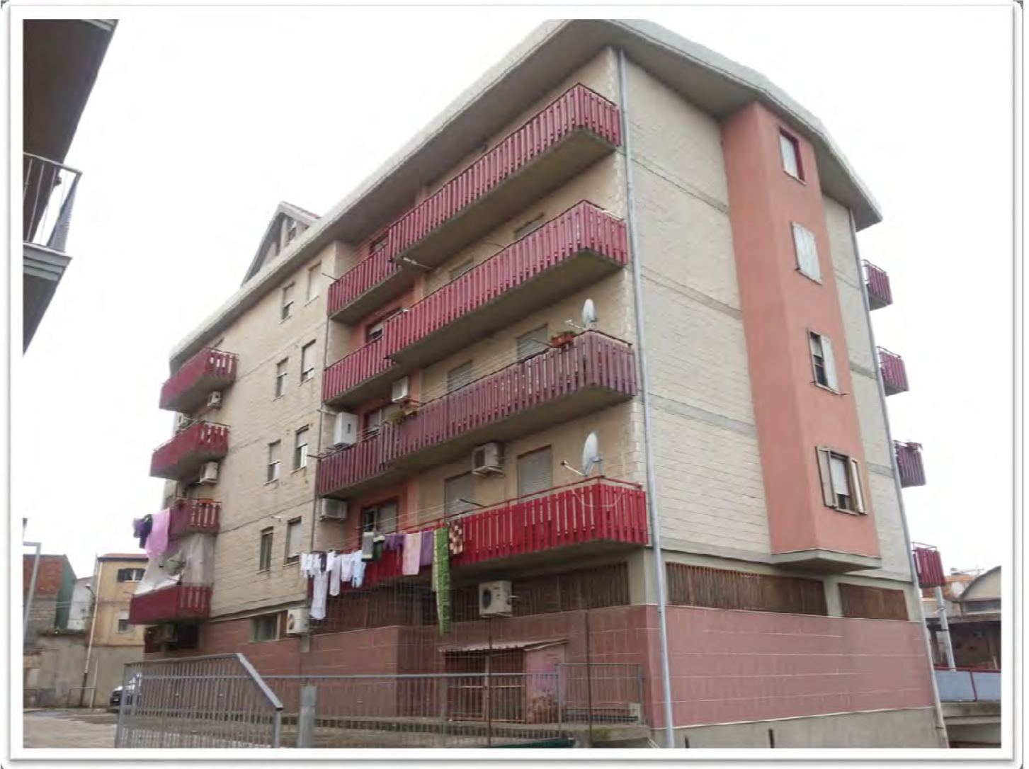
FOTO 2. Vista del fabbricato da Via C. Petrucci
